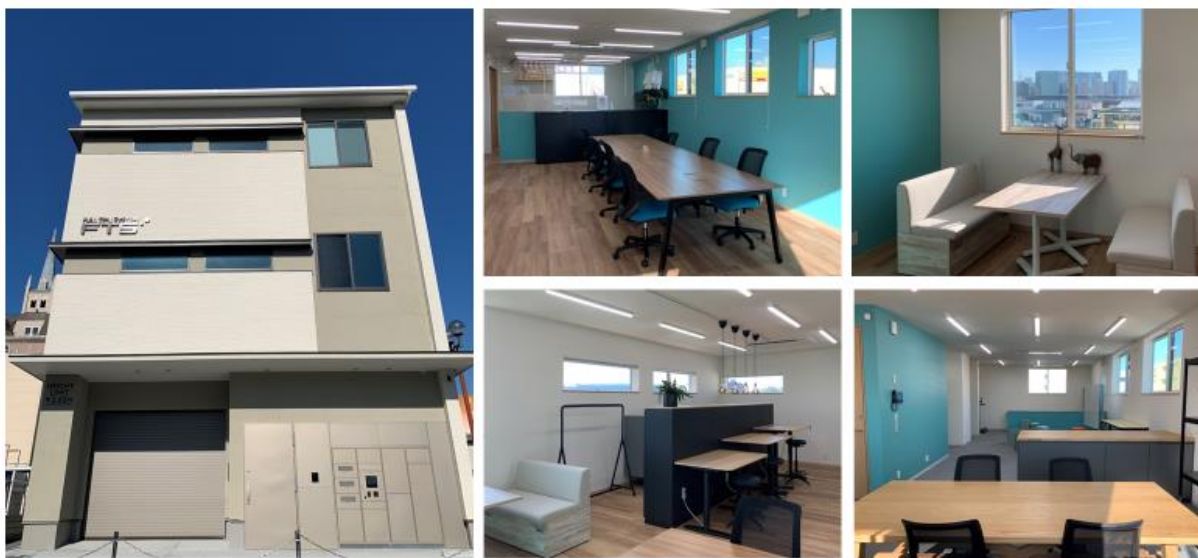
【フルタイムシステム横浜支店:2021年12月16日竣工】
